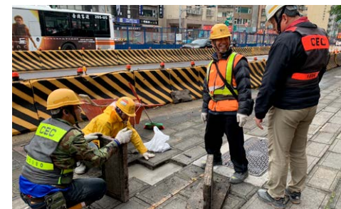
人行道破損修補作業
