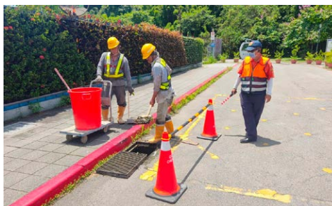
水溝清淤作業
