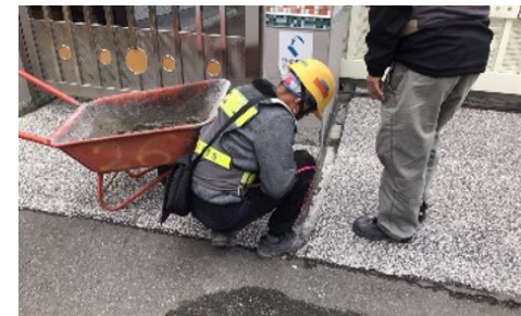
國小前方人行道破損補修作業
