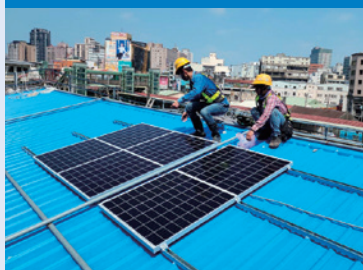
設置太陽能設備
