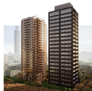
大安區商用大樓 5 臺北市 預計2029年完工
