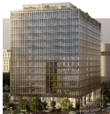
大直商用大樓改建 4 臺北市 預計2026年完工
