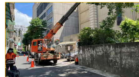
路樹修枝作業
