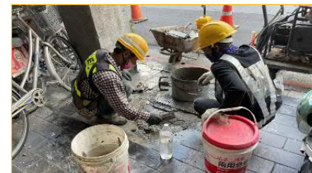
騎樓地磚膨拱處理
