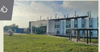
高雄市臨海水資源中心於 2019 年 3 月開工，提前於 2021 年 12 月完成第一期興建工程後，正式營運，大幅提升高雄地區水資源調度彈性。在興建過程中遭遇許多挑戰，由於既有之污水管無法斷水，施工作業僅能在水中完成，克服水管線與既有污水幹管銜接的挑戰；施工路徑鄰近石化管線、高雄捷運的輕軌及隧道增添難度，欣達環工團隊以專業技術一一克服，更順利提前完工。
