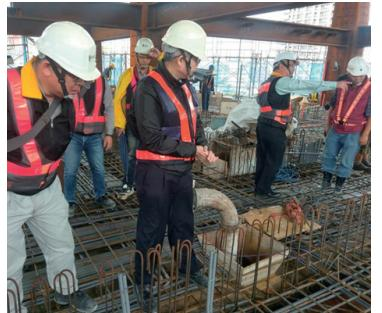
工程單位最高主管進行工地現場安衛聯合巡檢，發現任何安衛缺失，立即使用手機直接回報「工程單位專案主管巡檢」系統，通知責任區工程師回覆。如試樁工程作業開口未設防墜措施，需於線上說明改善狀況，並上傳相片作為對照紀錄。
