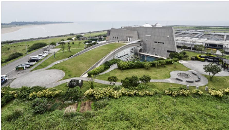
因應新北市政府推動淡水地區下水道系統之建設，欣達環工於 2005 年投資設立「北岸環保公司」以執行淡水地區之污水下水道系統 BOT 計畫。該案於下水道終端規劃設置「淡水水資源回收中心」，每日將 4.2 萬噸污水轉化處理成比現行法規要求更具優良水質之放流水，為當地居民創造美好生活環境與河岸親水空間，營運至今 12 年，深獲佳評。
